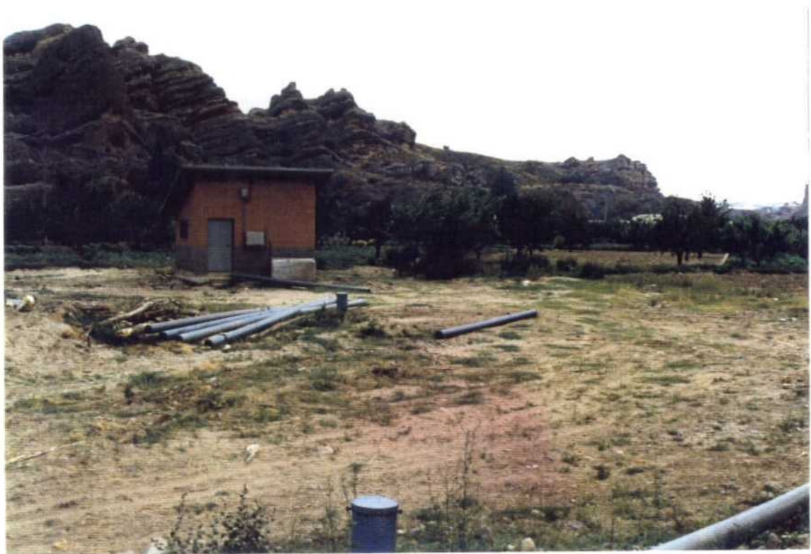
POZO CUEVA. ABASTECIMIENTO A AUTOL.
